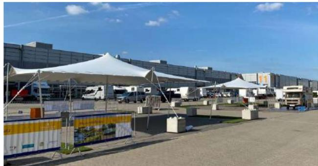
Abb.: Tenticle 75 qm mit statischer Berechnung mit Ballastierung
